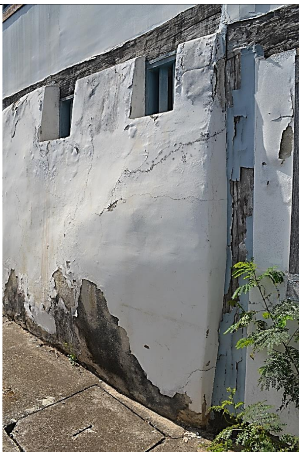
Imagem 07 – Embasamento / muro em alvenaria de pedra existente no subsolo, no lado esquerda da edificação. Fonte: Ney Nolasco.
