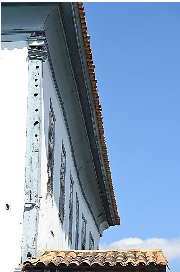
Imagem 14 – Cunhal de madeira do pavimento superior, existente no encontro da fachada principal com a lateral esquerda da edificação, com apodrecimento, degradação por ataques de insetos xilófagos, deformação acentuada, fratura e desprendimento de elemento do capitel. Observe também o desalinhamento da parede lateral esquerda da edificação. Fonte: Ney Nolasco.
