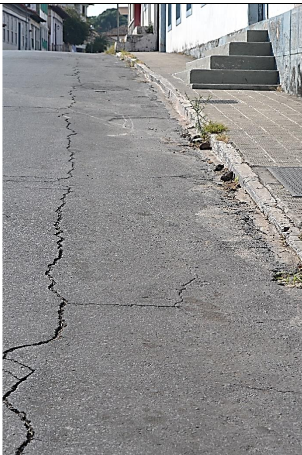
Imagem 03 – Rua em frente ao imóvel com trinca na pavimentação. Fonte: Ney Nolasco.
