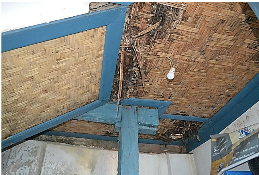
Imagem 53 – Forro da varanda de entrada, em esteira de taquara de bambu, parcialmente degradado. Fonte: Ney Nolasco.
