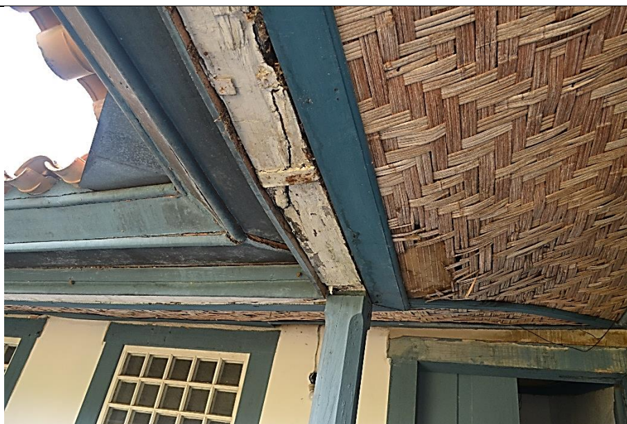
Imagem 19 – Frechal de madeira da varanda dos fundos do pavimento superior com fratura, apodrecimento parcial e deformação acentuada. Fonte: Ney Nolasco.
