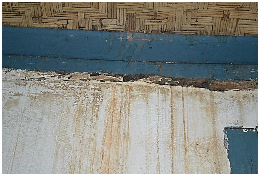
Imagem 38 – Parede de pau a pique do pavimento térreo, com infiltração de água pluvial vinda da varanda do pavimento superior. Fonte: Ney Nolasco.
