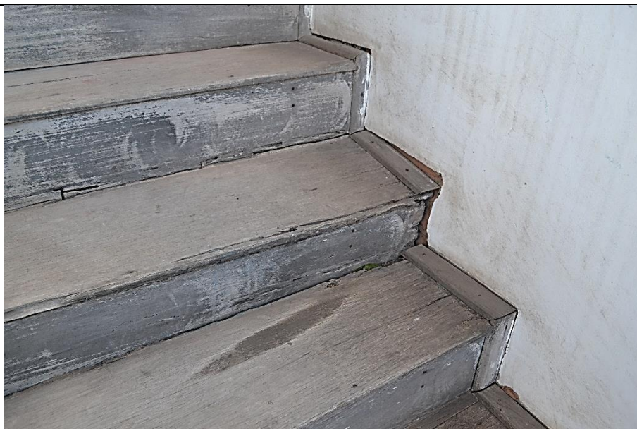
Imagem 48 – Pisos e espelhos de madeira degradados e soltos, existentes na escada dos fundos, do pavimento térreo de acesso ao superior. Fonte: Ney Nolasco.
