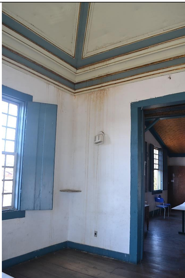
Imagem 56 – Forro de gamela do pavimento superior, com infiltração de águas pluviais, com início de degradação, inclusive do rodete. Fonte: Ney Nolasco.
