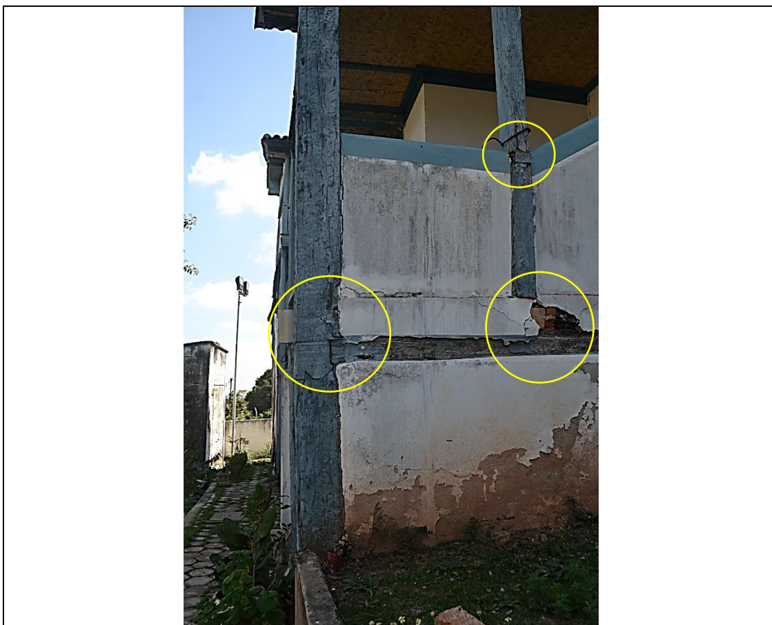
Imagem 24 – Pontos de apoios entre peças de madeira, posicionados nos fundos dos pavimentos térreo e subsolo, com degradações e insuficiências nas suas ligações. Fonte: Ney Nolasco.
