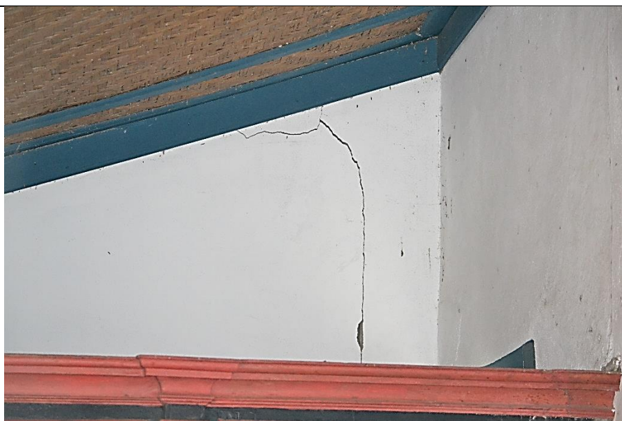
Imagem 33 – Parede em pau a pique, posicionada nos fundos da edificação (vista interna do salão 23 - pavimento superior), com trincas e inclinação, devido à degradação das estruturas autônomas de madeira que a suporta. Fonte: Ney Nolasco.
