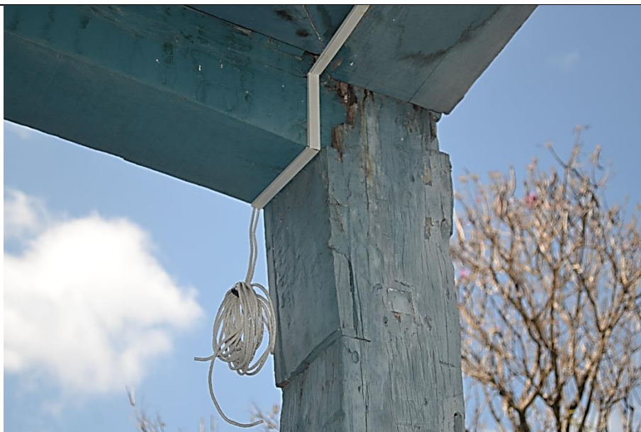
Imagem 25 – Ponto de apoio de cumeeira de madeira com vigas, nos fundos do pavimento térreo, com apodrecimento e insuficiência nas suas ligações - Fonte: Ney Nolasco.
