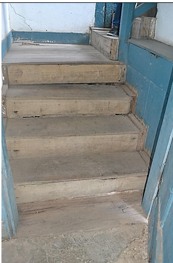
Imagem 50 – Pisos e espelhos de madeira degradados e soltos, existentes na escada dos fundos, do pavimento subsolo de acesso ao térreo. Fonte: Ney Nolasco.
