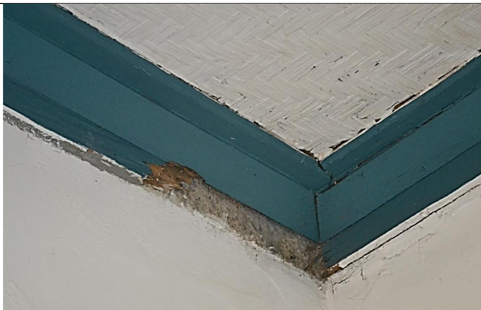
Imagem 10 – Madre de madeira do pavimento térreo (sustentação do pav. superior), com degradação por ataque de insetos xilófagos. Fonte: Ney Nolasco.
