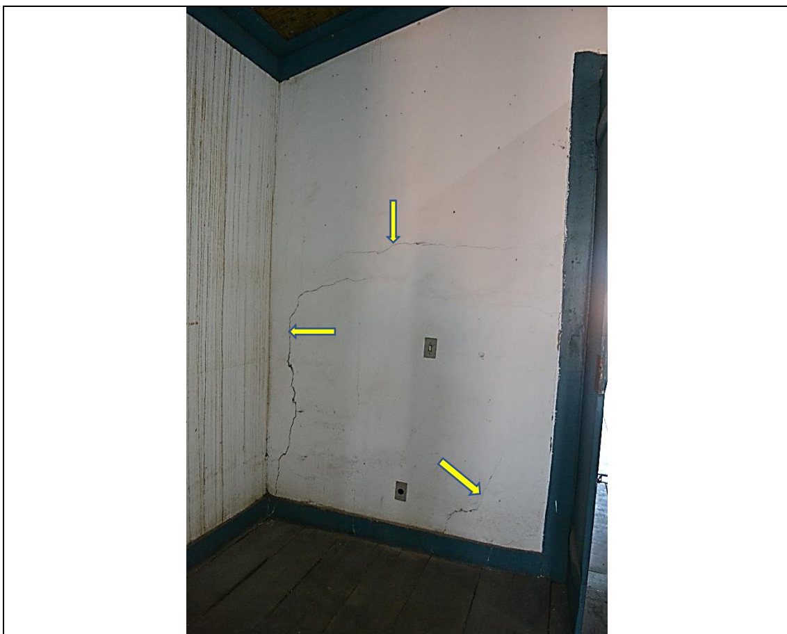
Imagem 36 – Parede de pau a pique, existente na sala 26 do pavimento superior, com trincas. Fonte: Ney Nolasco.
