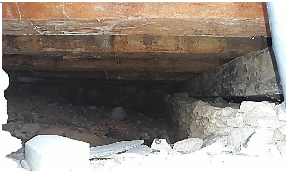
Imagem 02 – Porão baixo (sem utilização) do trecho anterior da edificação, onde se pode observar parte do embasamento (fundação aflorada), feito em alvenaria de pedra, uma viga baldrame em madeira maciça lavrada e alguns barrotes do assoalho do pavimento térreo. Fonte: Ney Nolasco.
