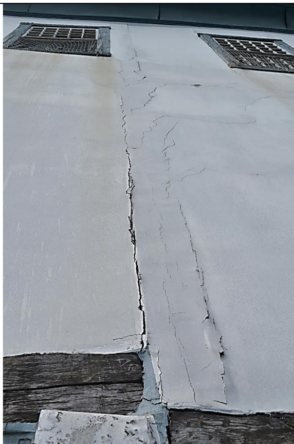
Imagem 31 – Esteio de madeira da fachada lateral esquerda, com trinca na junção com os panos de paredes. Fonte: Ney Nolasco.
