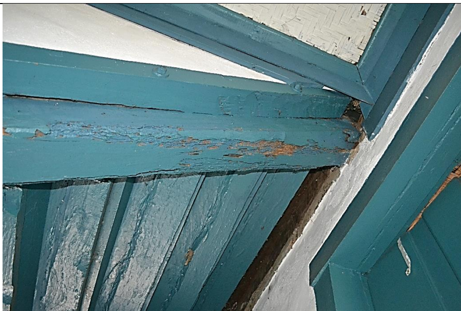
Imagem 52 – Estrutura suporte da escada interna de madeira, do pavimento térreo de acesso ao superior, com degradação por ataques de insetos xilófagos. Fonte: Ney Nolasco.
