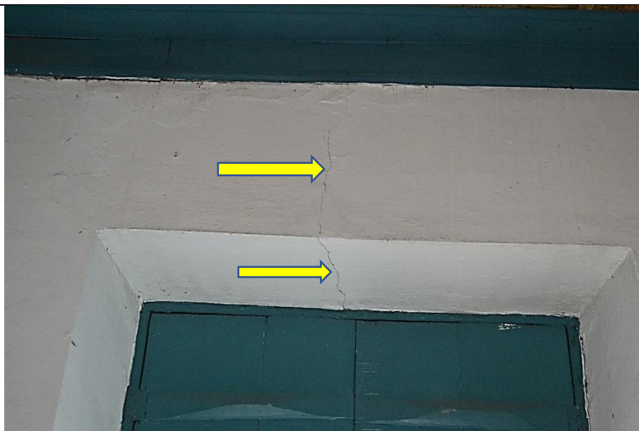
Imagem 34 – Parede em alvenaria de pedra da sala 104, do pavimento térreo, com trinca na verga. Fonte: Ney Nolasco.
