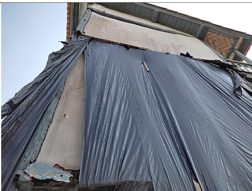
Imagem 28 – Parede em pau a pique, posicionada nos fundos da edificação, com trincas, desprendimento e inclinação, devido à degradação das estruturas autônomas de madeira que a suporta. Fonte: Ney Nolasco.
