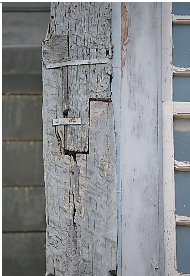
Imagem 22 – Sambladura na ligação entre trechos do esteio de madeira localizado nos fundos do pavimento térreo, com degradação e insuficiência no travamento entre as peças. Fonte: Ney Nolasco.
