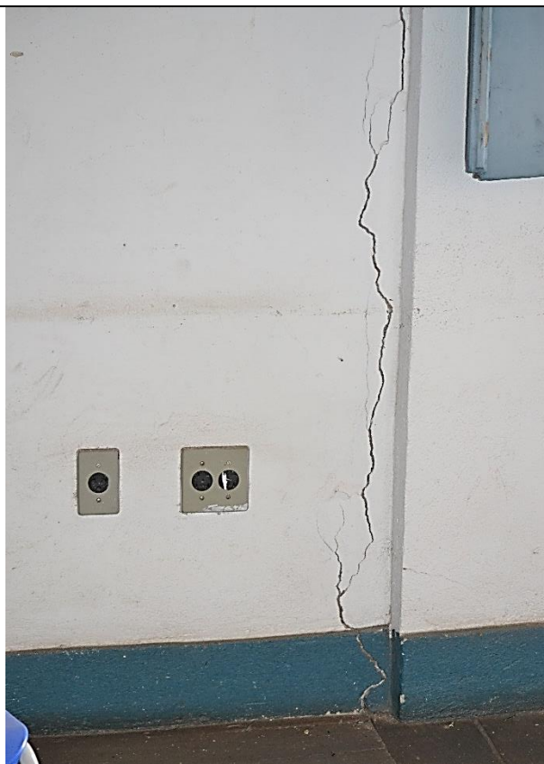
Imagem 29 – Parede em pau a pique, posicionada nos fundos da sala, com estufamento para fora. Fonte: Ney Nolasco
