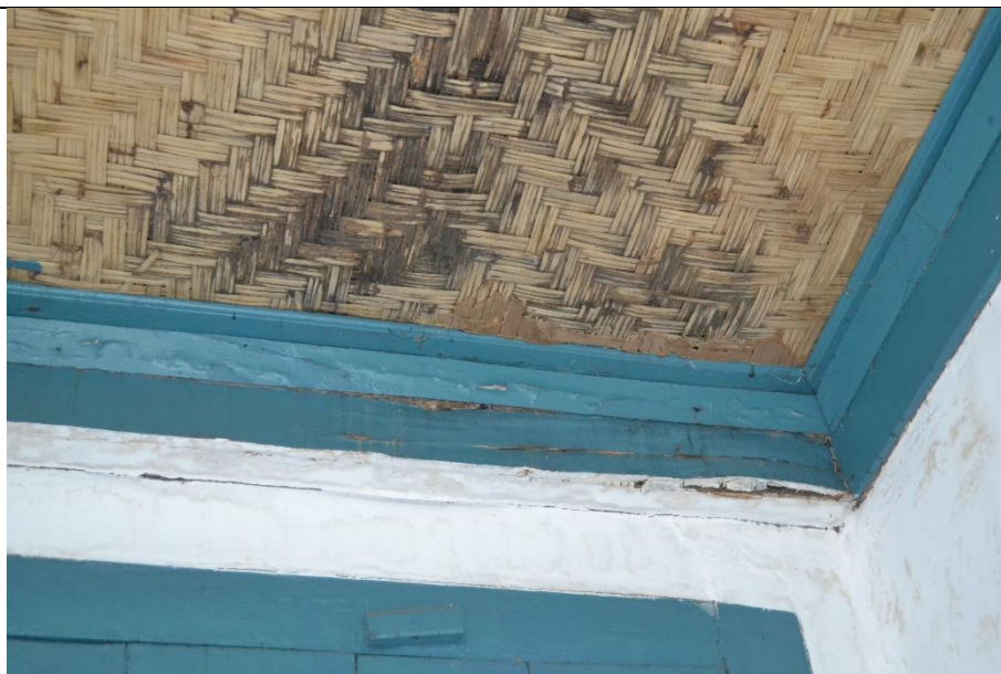
Imagem 55 – Forro feito de taquara de bambu do pavimento térreo, com infiltração de águas pluviais, com degradação, inclusive do rodapê e da parede. Fonte: Ney Nolasco.
