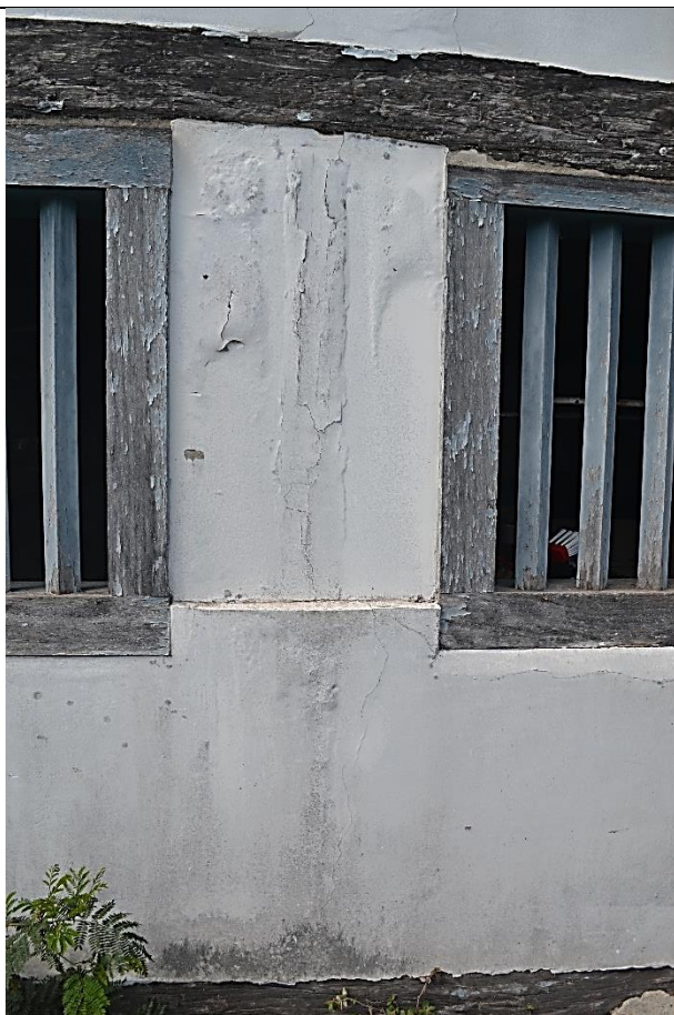
Imagem 15 – Madre de madeira sobre a parede lateral esquerda, do pavimento subsolo com apodrecimento parcial. Observa-se também indicações da degradação de esteio no local. Fonte: Ney Nolasco.
