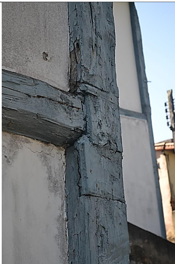
Imagem 23 – Ponto de apoio entre madre e cunhal de madeira, nos fundos do pavimento subsolo com apodrecimento parcial. Fonte: Ney Nolasco.
