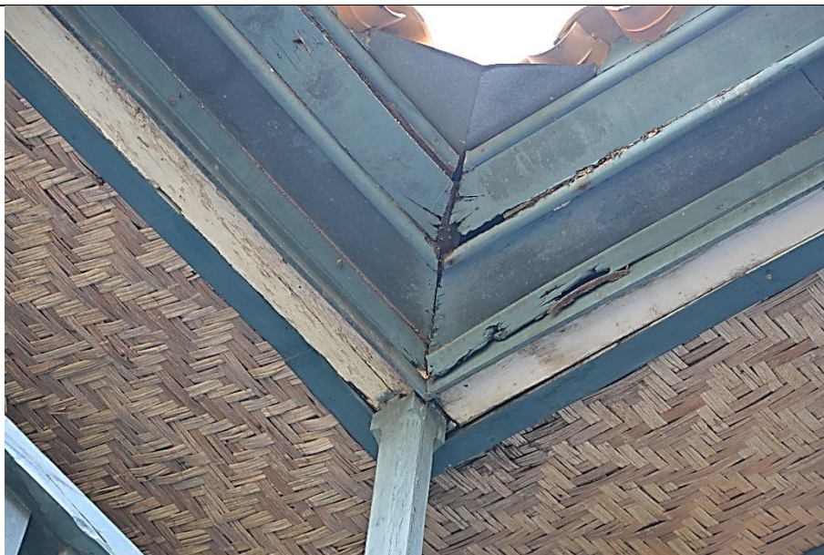
Imagem 58 – Beiral da fachada posterior, junto à varanda, com apodrecimento parcial devido às infiltrações de águas pluviais. Fonte: Ney Nolasco.
