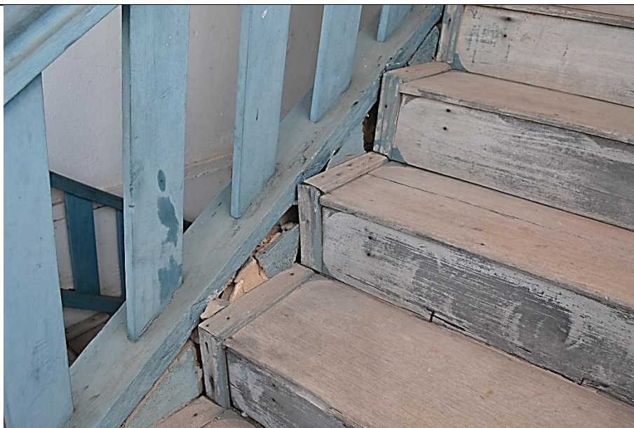
Imagem 49 – Pisos e espelhos de madeira degradados e soltos, existentes na escada dos fundos, do pavimento térreo de acesso ao superior. Fonte: Ney Nolasco.
