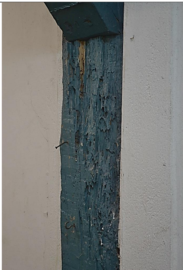
Imagem 13 – Esteio de madeira com mão francesa, embutido na parede lateral esquerda do auditório do pavimento térreo, com degradação por ataque de insetos xilófagos. Fonte: Ney Nolasco.
