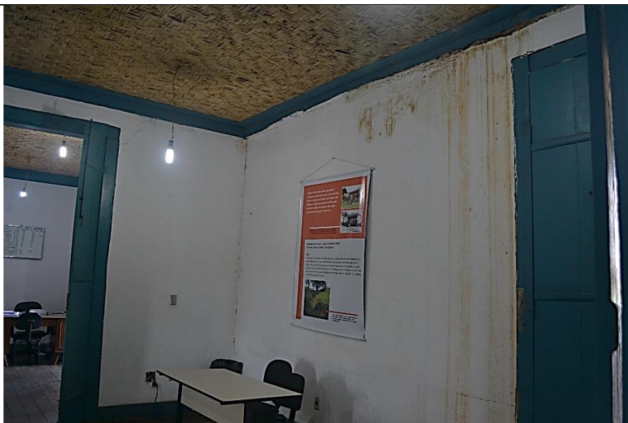
Imagem 57 – Forro feito de taquara de bambu do pavimento térreo, com infiltração de águas pluviais, com degradação, inclusive do rodafino. Fonte: Ney Nolasco
