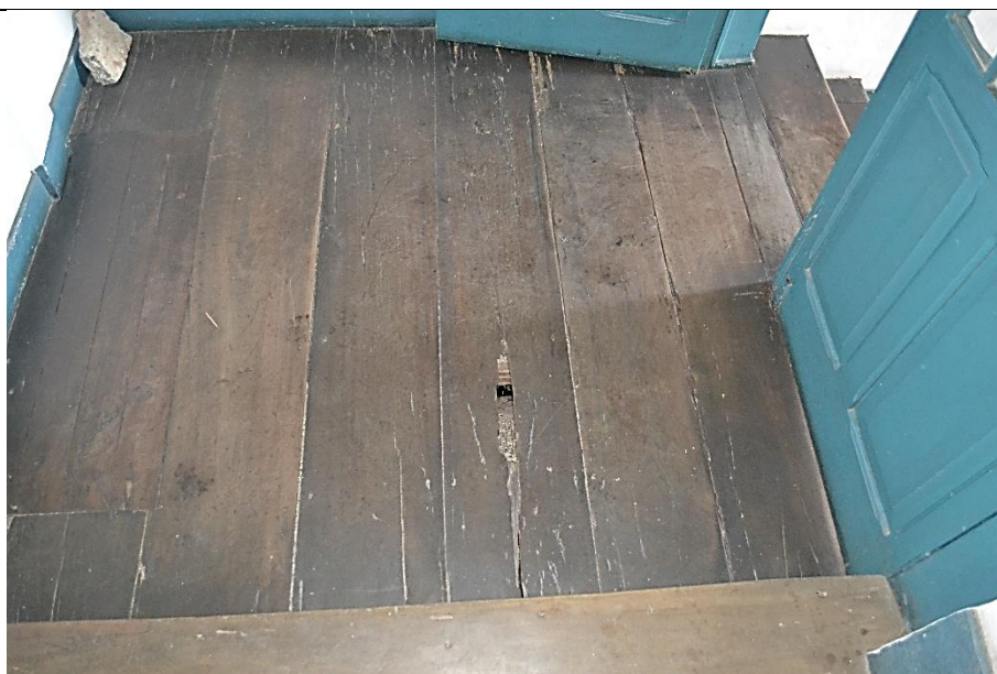
Imagem 46 – Piso assoalhado do pavimento térreo com trincas e lacunas parciais. Fonte: Ney Nolasco.
