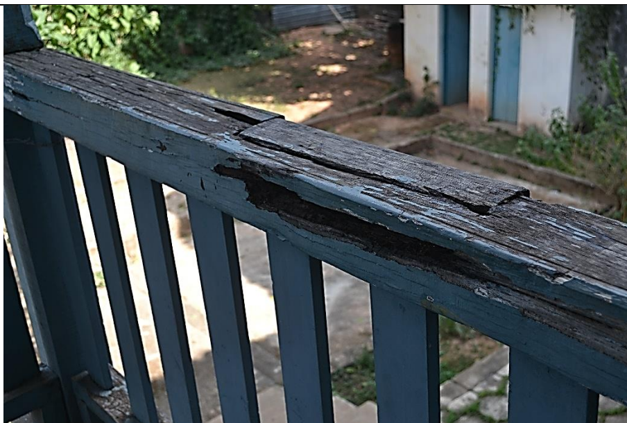
Imagem 17 – Peitoril de madeira do guarda-corpo, da varanda dos fundos do pavimento térreo, com apodrecimento parcial. Fonte: Ney Nolasco.
