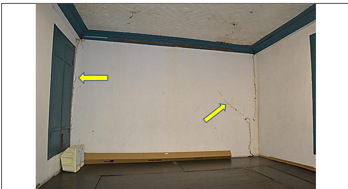
Imagem 32 – Parede em pau a pique, posicionada nos fundos da edificação (vista interna do auditório - pavimento térreo), com trincas, desprendimento e inclinação, devido à degradação das estruturas autônomas de madeira que a suporta. Fonte: Ney Nolasco.
