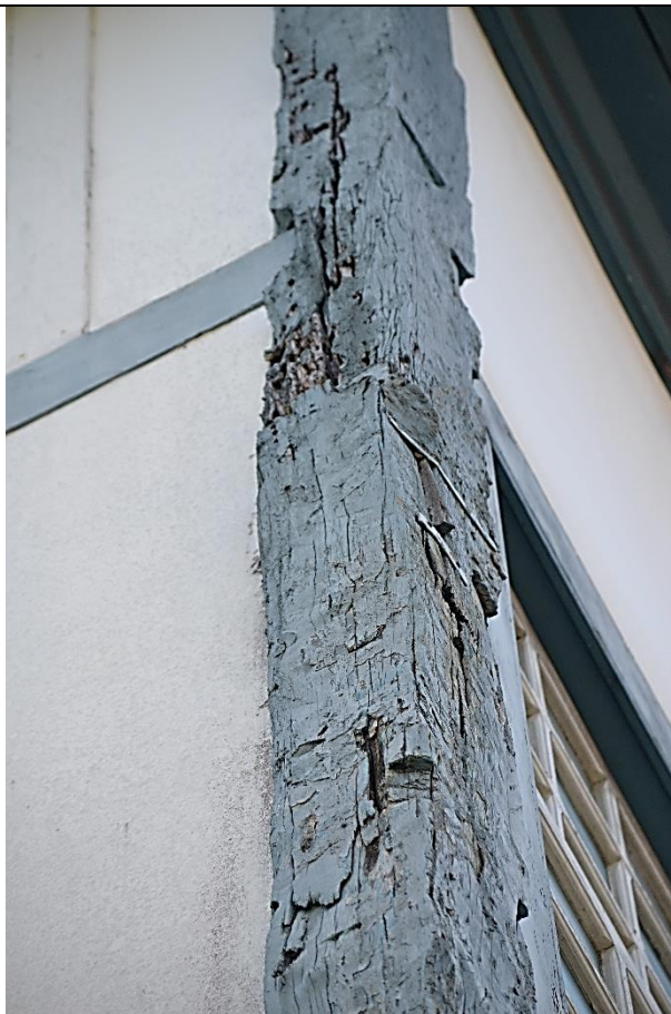
Imagem 20 – Cunhal de madeira, dos fundos do pavimento térreo, com fraturas e apodrecimento parcial. Fonte: Ney Nolasco.
