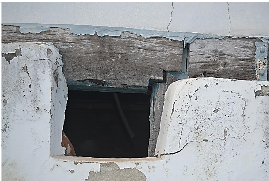
Imagem 26 – Apoio viga baldrame do pavimento térreo, feito em sambladura sem travamento. Fonte: Ney Nolasco.
