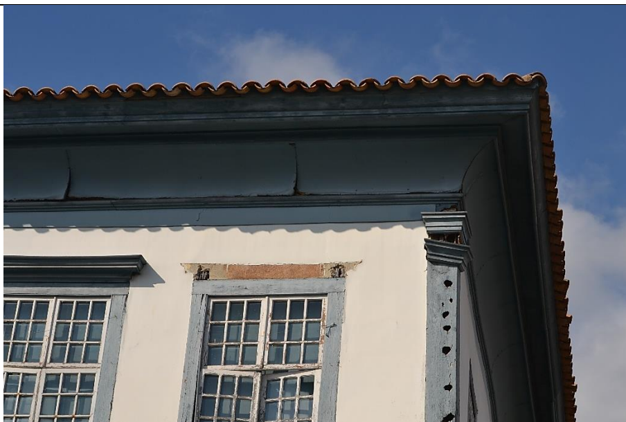
Imagem 59 – Beiral da fachada principal, com desprendimento parcial de elementos componentes e risco de queda. Fonte: Ney Nolasco.
