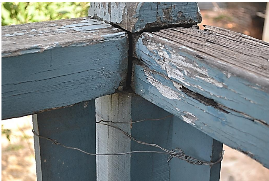
Imagem 18 – Guarda-corpo de madeira da varanda nos fundos do pavimento térreo, com apodrecimento no ponto de apoio. Fonte: Ney Nolasco.
