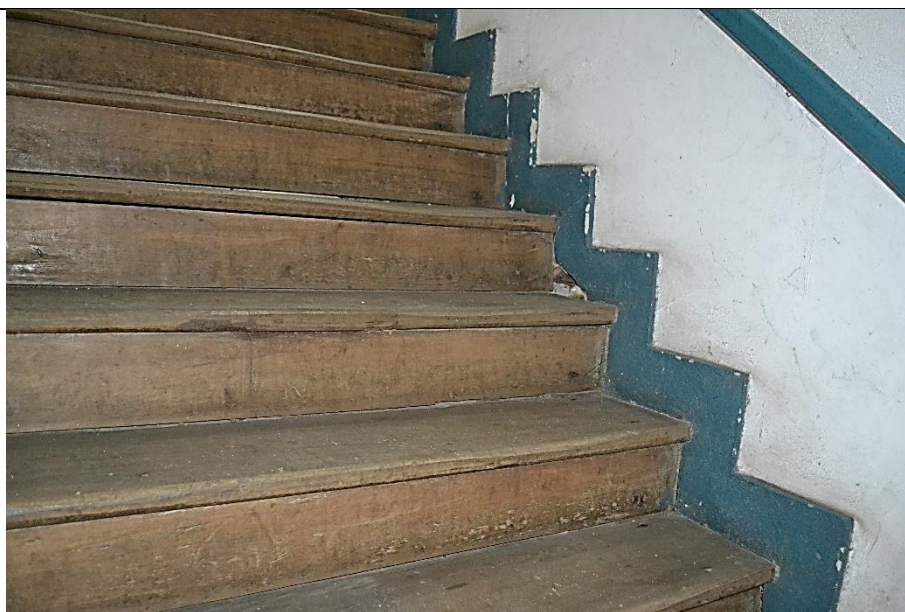
Imagem 51 – Pisos e espelhos de madeira degradados e desnivelados, existentes na escada interna do pavimento térreo, de acesso ao superior. Fonte: Ney Nolasco.
