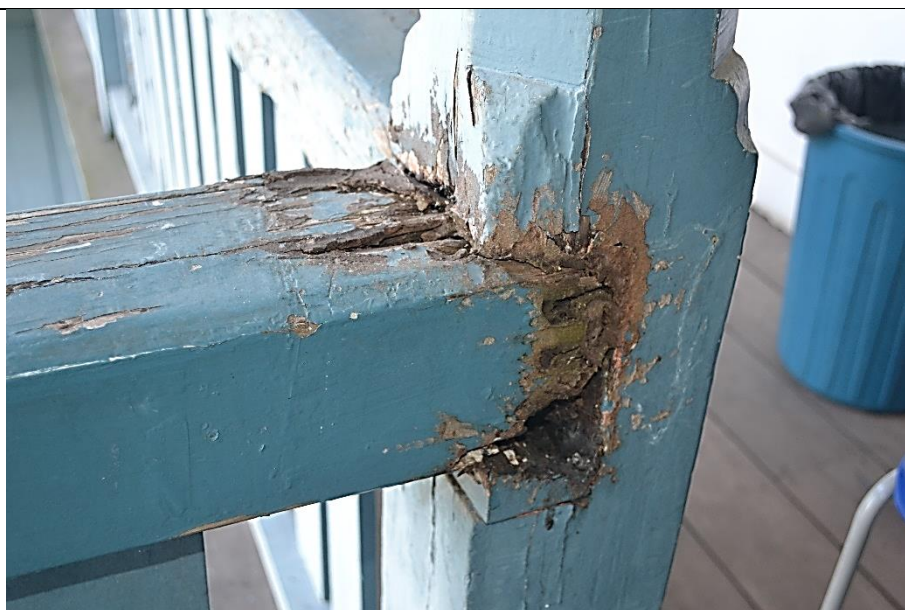
Imagem 16 – Peitoril de madeira, do guarda-corpo da varanda dos fundos, do pavimento superior, com apodrecimento no ponto de apoio. Fonte: Ney Nolasco.
