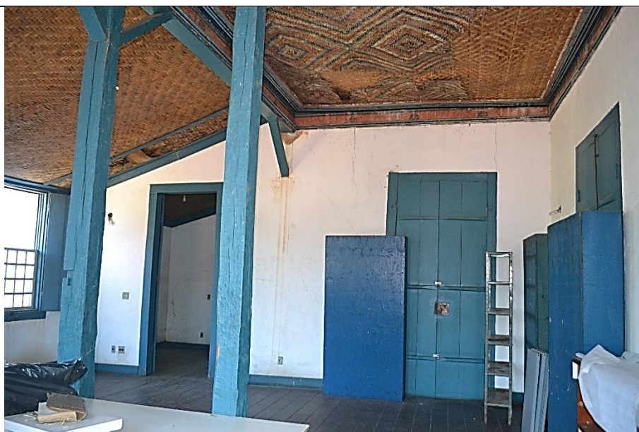
Imagem 54 – Forro em taquara de bambu do pavimento superior parcialmente degradado. Observe também as marcas do escorrimento de águas pluviais nas paredes e as colunas de madeira com fraturas longitudinais. Fonte: Ney Nolasco.
