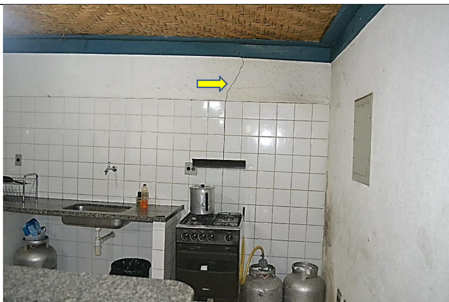
Imagem 05 – Muro de contenção em alvenaria de pedra, existente na cozinha, no subsolo, com trinca. Fonte: Ney Nolasco.
