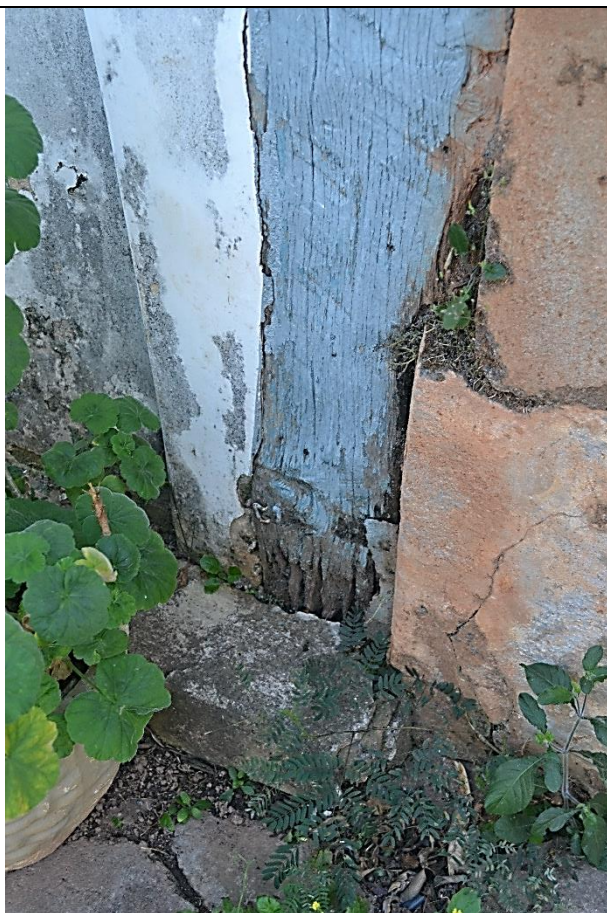
Imagem 12 – Pé de esteio de madeira, posicionado nos fundos do pavimento subsolo, com apodrecimento parcial. Fonte: Ney Nolasco.
