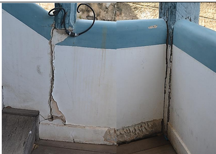
Imagem 35 – Parede em alvenaria de tijolos cerâmicos, existente nos fundos da edificação, pavimento térreo, onde se observa o seu desprendimento das peças de madeira. Fonte: Ney Nolasco.
