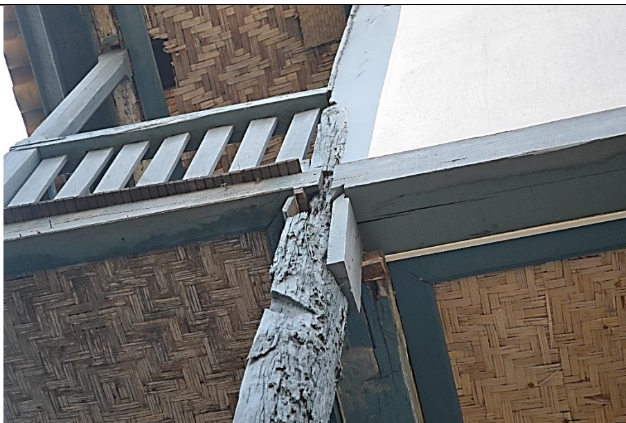
Imagem 21 – Esteio de madeira, de sustentação do pavimento superior, posicionado na fachada posterior, com apodrecimento, degradação por ataque de insetos xilófagos, com enxertos insuficientes no ponto de apoio das vigas. Fonte: Ney Nolasco.
