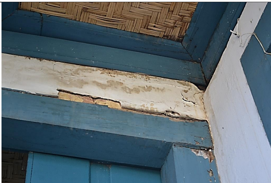
Imagem 39 – Parede de pau a pique do pavimento superior, com infiltração de água pluvial vinda do telhado. Fonte: Ney Nolasco.
